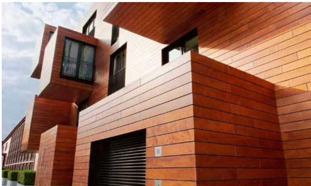
Les façades en bois traité par imprégnation offrent des propriétés isolantes nettement supérieures à celles en bois non traité.
