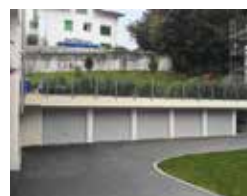
Garages en ligne, sous terrain avec auvent et allège
