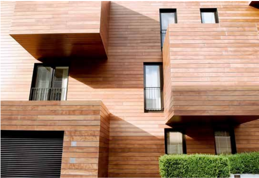
Eine Aussenwand prägt nicht nur das Aussehen, sondern beeinflusst auch Dauerhaftigkeit und Wetterfestigkeit.
