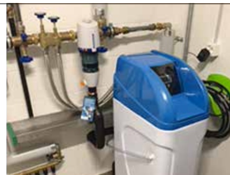
Wasserenthärtungsanlage
