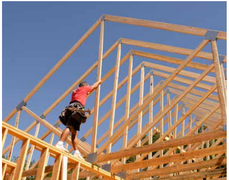
Beim sogenannten Hybridbau werden für die Aussenhülle Holzbauelemente eingesetzt.
