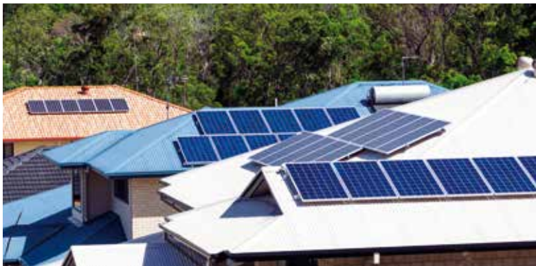
Eine Wärmepumpe lässt sich erfolgreich mit Photovoltaik- und Solaranlagen kombinieren.
