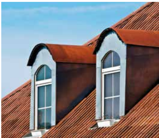
Gaubenfenster haben den Vorteil, dass sich einfache Wandfenster mit einem Dreh-Kipp-Mechanismus einsetzen lassen.
