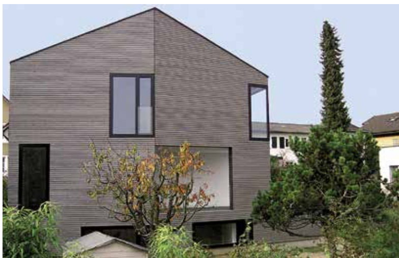
Anbau Höhenweg, Binningen BL.
