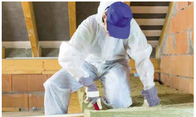
Bei Arbeiten an der Aussenhülle ist es sinnvoll, sich zunächst mit dem Dach zu beschäftigen.
