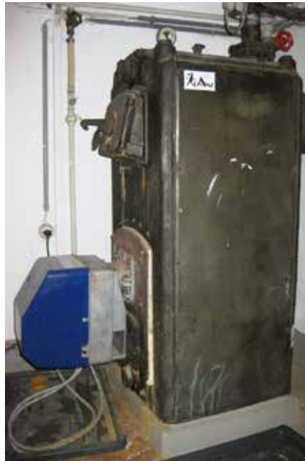
Alte Ölheizungen nehmen viel Platz weg und verlieren an Wärme. Moderne Wandheizgeräte benötigen weniger Platz, dadurch entsteht frei nutzbarer Raum.
