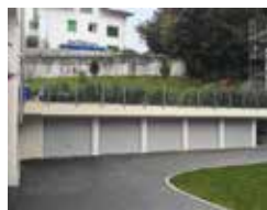
Reihengaragen im Hang mit Vordächern und Brüstungen
