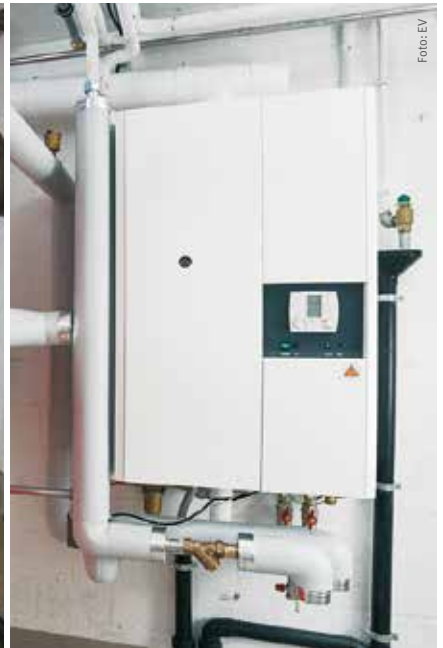
Alte Ölheizungen nehmen viel Platz weg und verlieren an Wärme. Moderne Wandheizgeräte benötigen weniger Platz, dadurch entsteht frei nutzbarer Raum.
