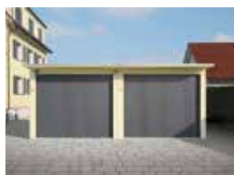
Doppelgarage mit Kipptoren und Vordach
